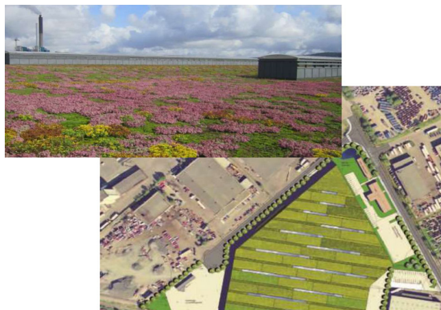
Obr.: Zelená střecha ve spalovně a recyklačním závodě Haraldrud |
