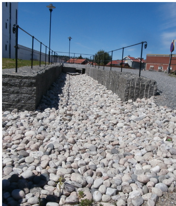
Obr.: Koryto pro odvádění nadbytečné vody, Skien | Zdroj: CI2, o. p. s.
