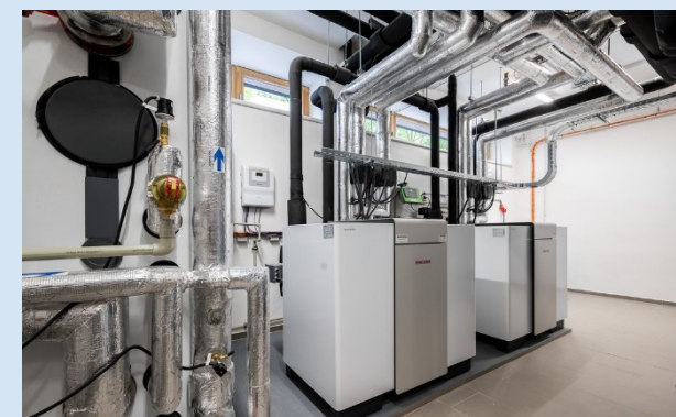
Obrázek 87 Biosoláry, popínavé rostliny 75 , rekuperace. Zdroj: https://www.subterra.cz/reference/rekonstrukce-coph-ceskobrodka-v-praze/
