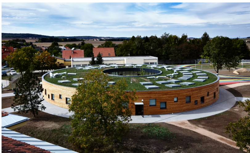
Obrázek 78 ZŠ Libeznice. Zdroj: Projektil Architekti 71
