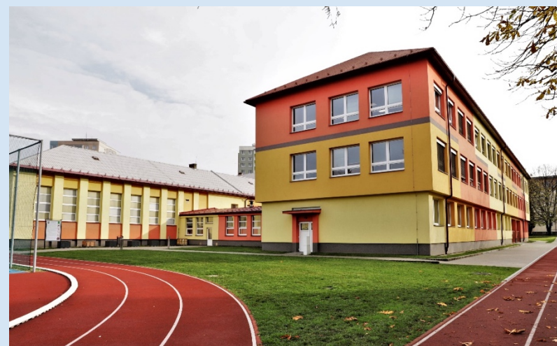
Obrázek 71 Nebezpečné povrchy, příznivá reflektance střechy
