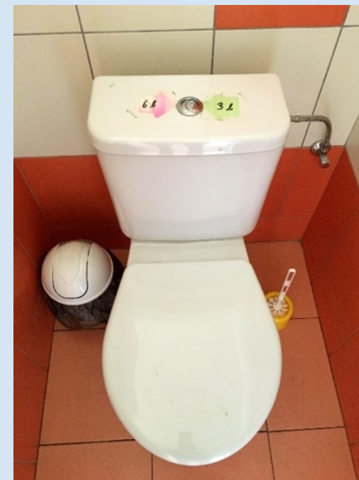
Obrázek 41 Měkké opatření – upozornění na šetření s vodou. Úsporné splachování WC, ZŠ Zbihor
