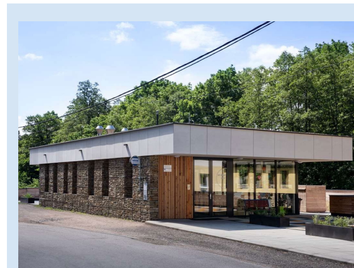
Obrázek 13 Stavební materiál kámen a dřevo. Zdroj: ZŠ Nekoř
