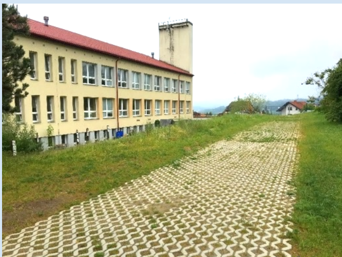
Obrázek 17 Propustné a barevně vhodné povrchy – zatravnovací dlažba, štěrk a kameny, umělý trávník, ZŠ Zbiroh
